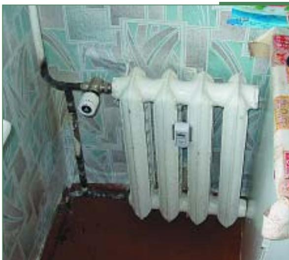
▼ Рис. 1. Термостатический регулятор «Данфосс» и распределитель тепла на радиаторе в квартире жилого дома в г. Белорецке
