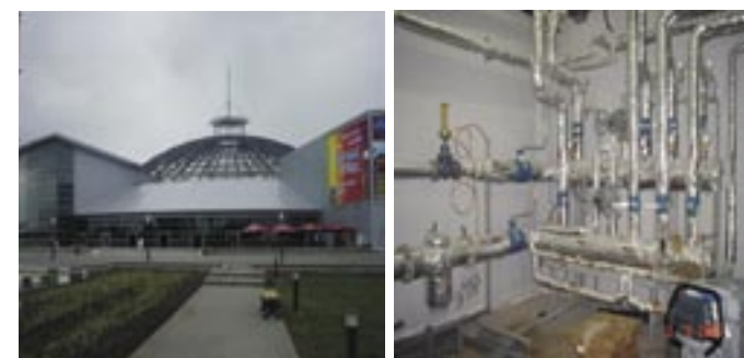
Развлекательный комплекс «Думан». Для автоматизации применены электронный регулятор ECL Comfort 300, регулятор перепада давления, седельные регулирующие клапаны, редукторные электроприводы для независимой схемы присоединения контуров отопления и горячего водоснабжения.
