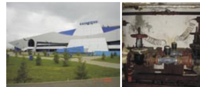
Спортивный комплекс «Казахстан». Для автоматизации теплового пункта применены регуляторы температуры прямого действия для контура горячего водоснабжения.
